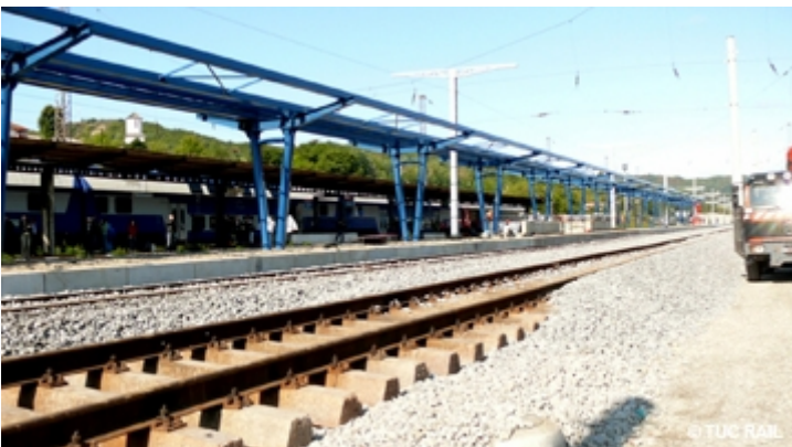
Modernisering en vernieuwing van de spoorlijn Boekarest - Brasov in Roemenië
