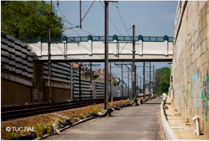
Exemple d'un pont-rail aménagé pour le passage des piétons, cyclistes ou cavaliers : la passerelle pour piétons et cyclistes à Hoeilaart
