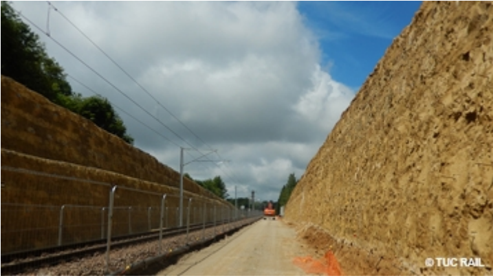
Modernisering en vernieuwing van de spoorlijn Campina-Predeal in Roemenië
